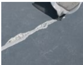
Kép: Kitöltött repedések
