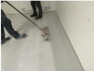
keresztirányú hengerezés a szőnyegen
