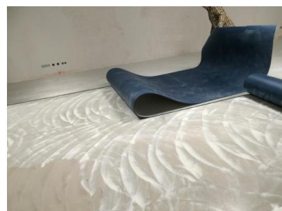
szőnyeg lefektetése a ragasztóba
